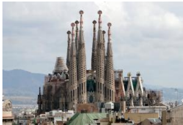
Figura 13: Fachada da Paixão com as torres sineiras. Os perfis parabólicos das torres permitiram uma altura maior sem contrafortes.
