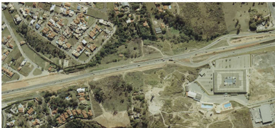
Figura 4. Imagem do entorno da Rodovia Raposo Tavares, entre os quilômetros 100 e 94, na cidade de Sorocaba no ano de 2000.
