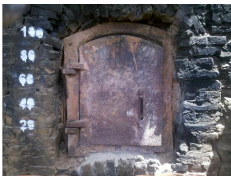
Fig. 6. Câmara de combustão.
