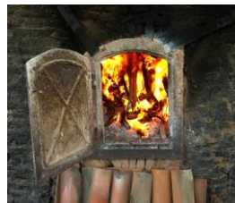
Fig. 3. Câmara de combustão.
