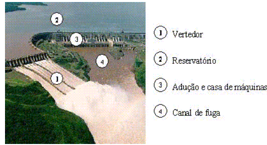
Figura 1: Elementos de um usina hidrelétrica.
